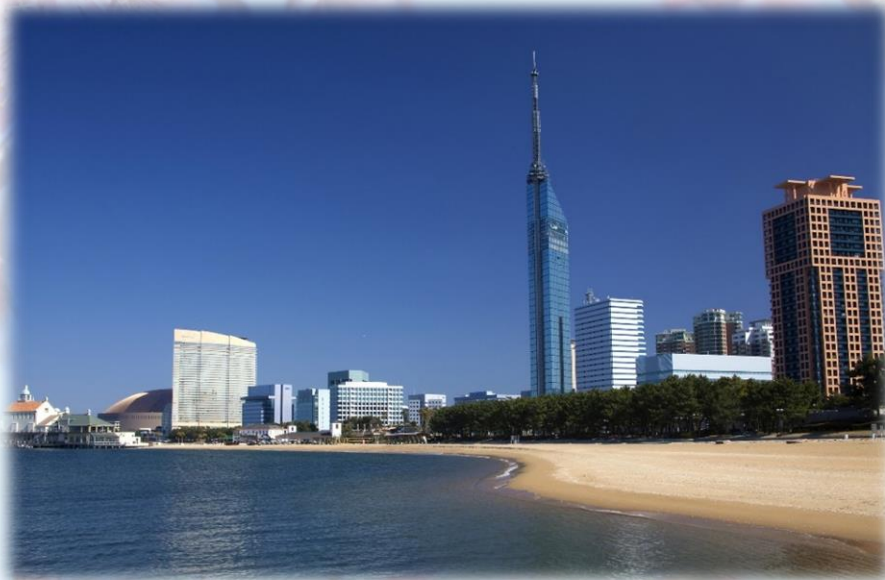
写真提供：福岡市
